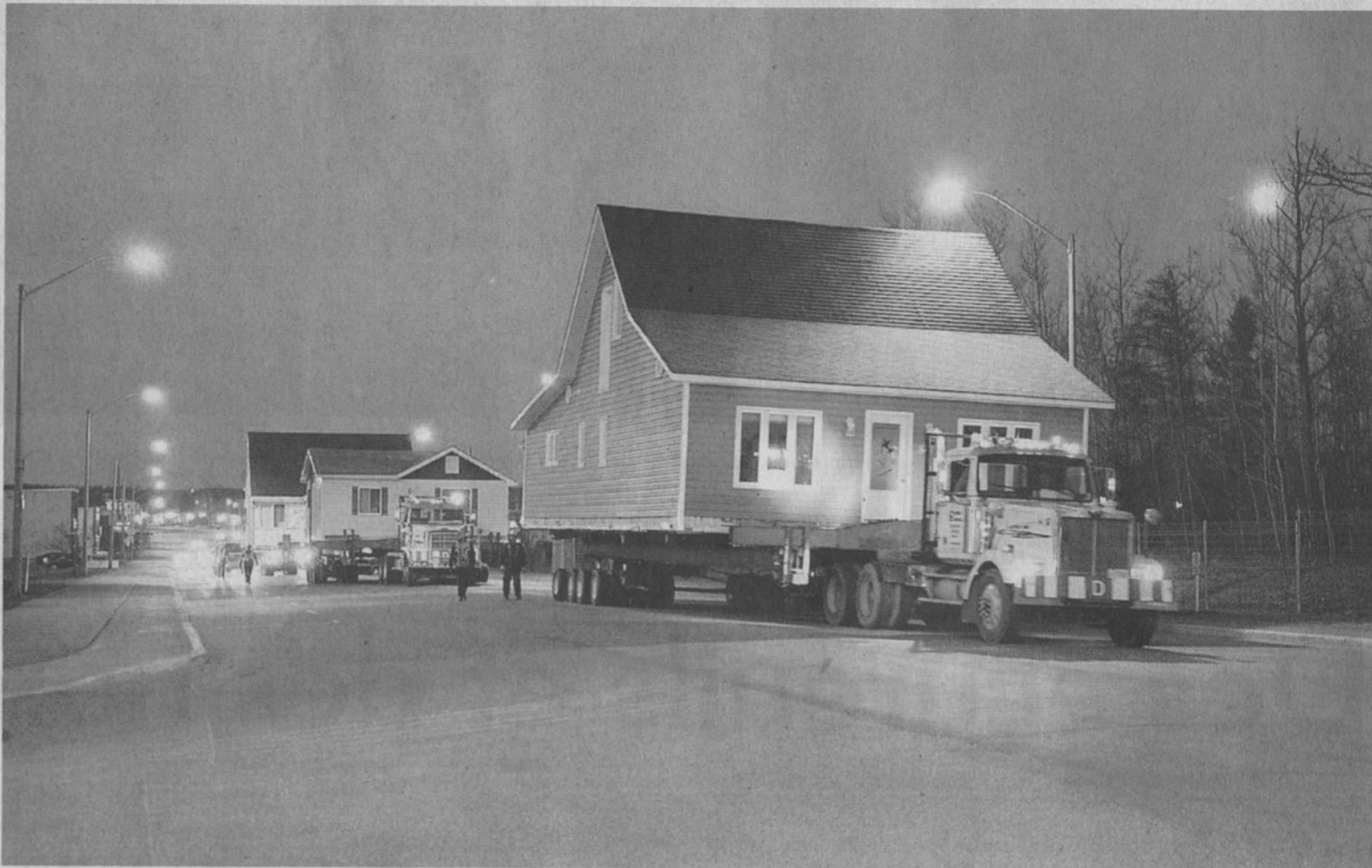
Le projet de mine à ciel ouvert à Malartic a entraîné le déménagement d'un quartier complet comptant 205 maisons.
